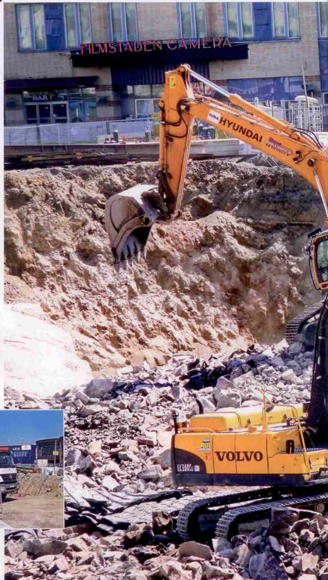
Snart dags för en ny salva. Det blir många små sprängningar med tanke på de närliggande fastigheterna och allt folk som är i rörelse i närheten.
