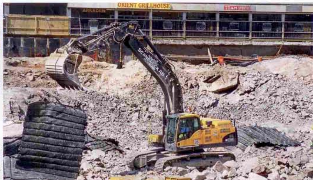
En sprängmatte lyfts på plats. Ombyggnaden av Täby centrum är ett mångmiljardprojekt som även omfattar infartsvägar och bostäder.
