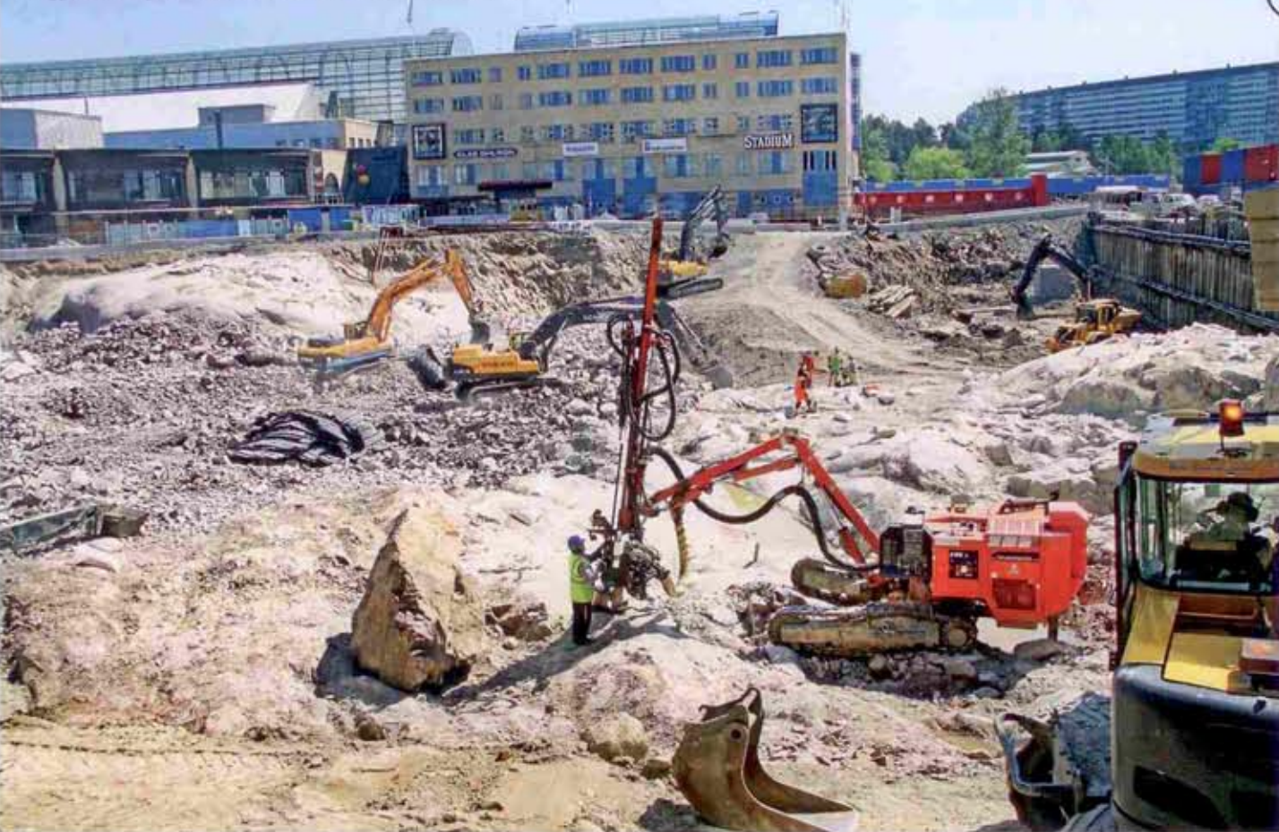
Snart dags för en ny salva. Det blir många små sprängningar med tanke på de närliggande fastigheterna och allt folk som är i rörelse i närheten.
